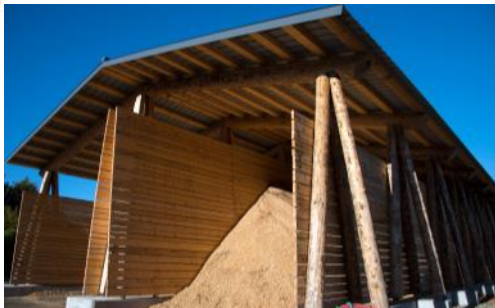
Plateforme de stockage bois énergie - hangar à plaquette - Syndicat Mixte de More - Jura-sapin épicea
