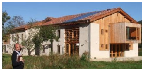
Rénovation Ferme d'Icart en pôle d'activités - Communauté de communes du Séronais - Ariège (09)
