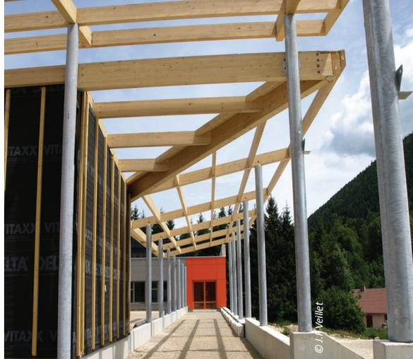
Le bâtiment est composé d'une structure en ossature mixte bois béton en murs rideaux en panneau ossature bois et en caissons pour la toiture en sapin, épicéa. Une attention particulière a été portée sur l'utilisation de matériaux performants d'un point de vue environnementale. L'isolant en laine de bois a été insufflé dans les caissons. La toiture est végétalisée et l'organisation en U permet de protéger des vents dominants et de bénéficier du maximum d'apport solaire.
