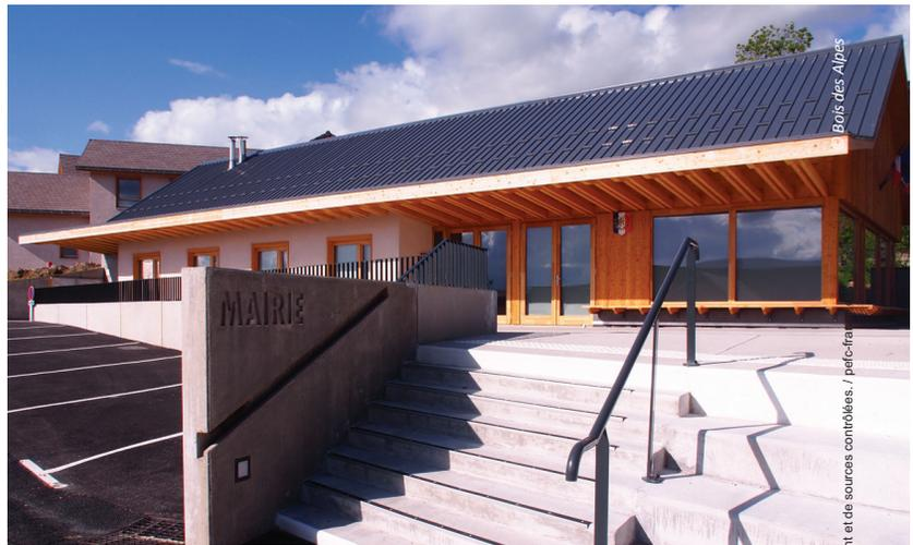
Sensibilisé à la question de l'énergie grise, le maître d'ouvrage a également privilégié des matériaux biosourcés pour l'isolation (blocs de chanvre notamment) et une chaudière bois à granulés pour le chauffage (diffusion assurée par un plancher chauffant).
