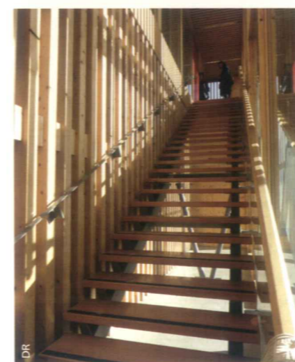
L'escalier intérieur, lui aussi en bois.
