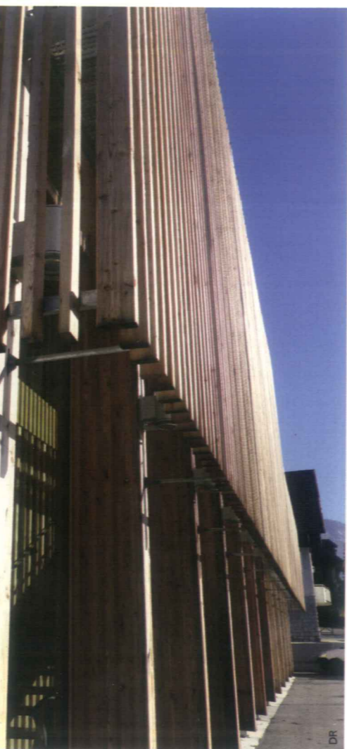
À l'avant du bâtiment, les résilles extérieures sont faites de mélèze des forêts des Hautes-Alpes.
